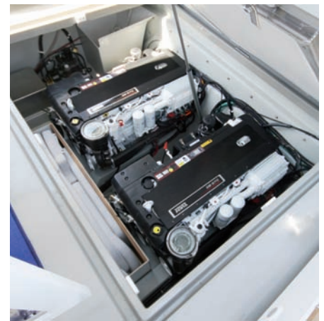
Saubere, servicefreundliche Installation der beiden Volvo Penta D6-370 Diesel-Boliden.
